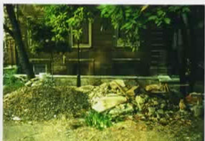
Un angolo del cortile prima dell'intervento.
